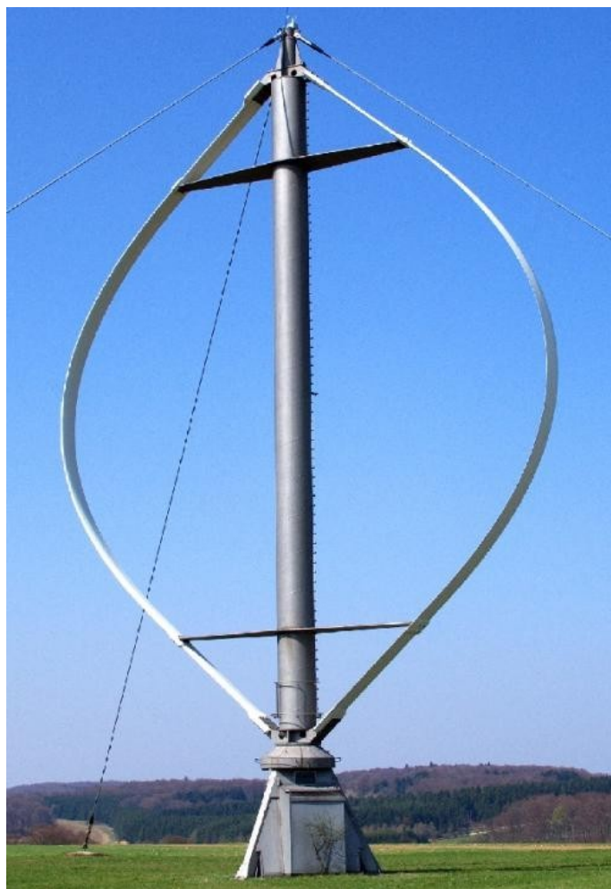
Рисунок 1.8– Внешний вид ротора Дарье
